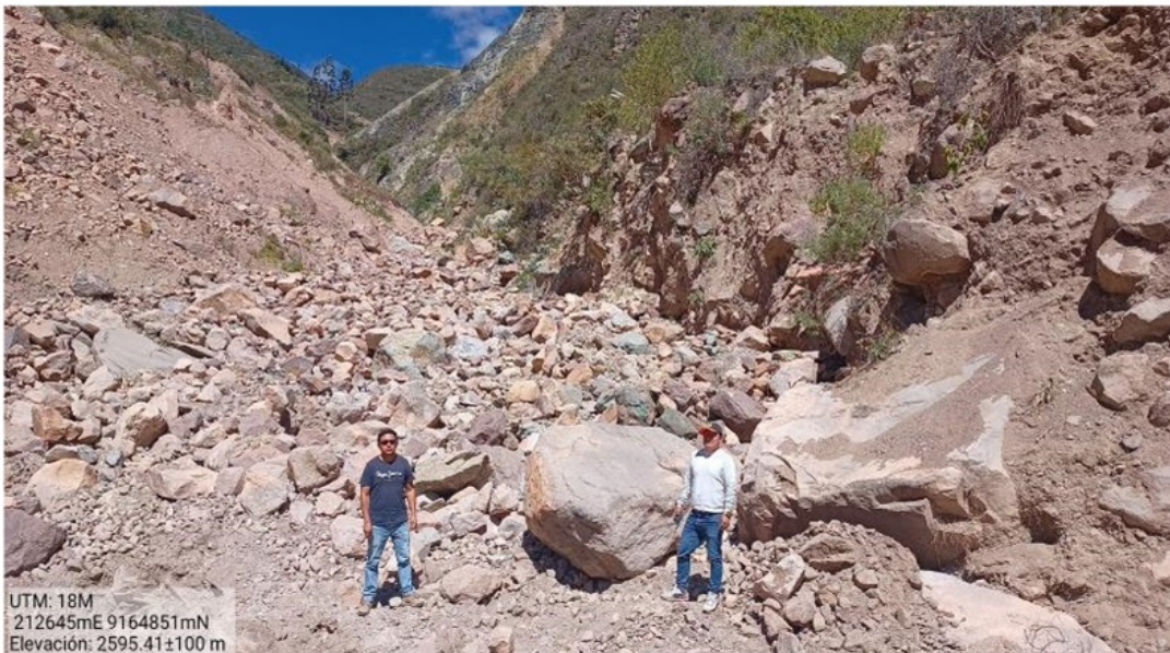
FIGURA N°03: SE PUEDE VISUALIZAR LA COLMATACION EXISTENTE EN LA QUEBRADA SUCNAYA.
